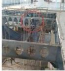
*Gambar 5.1 Seorang Pekerja tidak menggunakan body harness pada saat bekerja di ketinggian*
